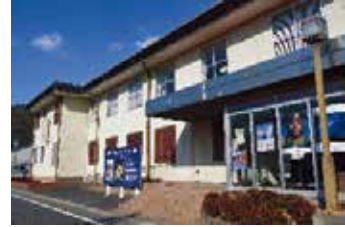
井原市文化財センター 「古代まほろば館」 井原市井原町333-1
